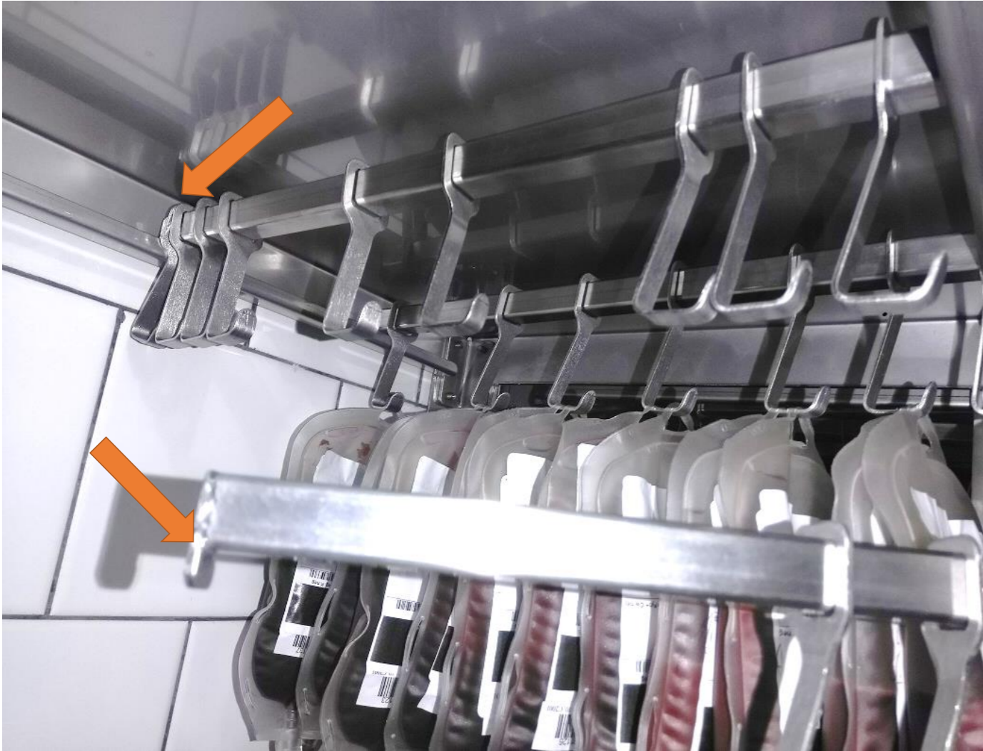
Detail ukončení tyče a podpěrné uchycení
